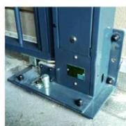
De nombreuses solutions de pose existent, notamment la possibilité d'installer le pilier sur une réhausse métallique.
