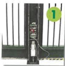
**Le motoréducteur et le guidage** haut sont montés flottants sur le pilier pour permettre d'absorber de petites dénivellations du socle béton sans induire le blocage mécanique.
